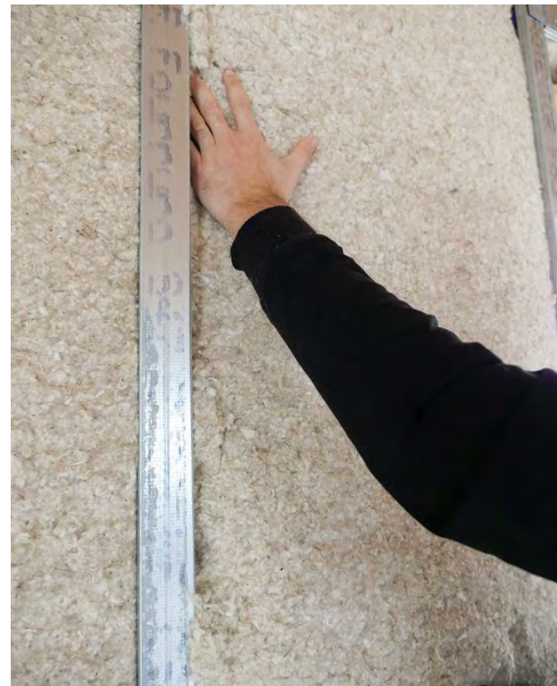
Isolation des cloisons
