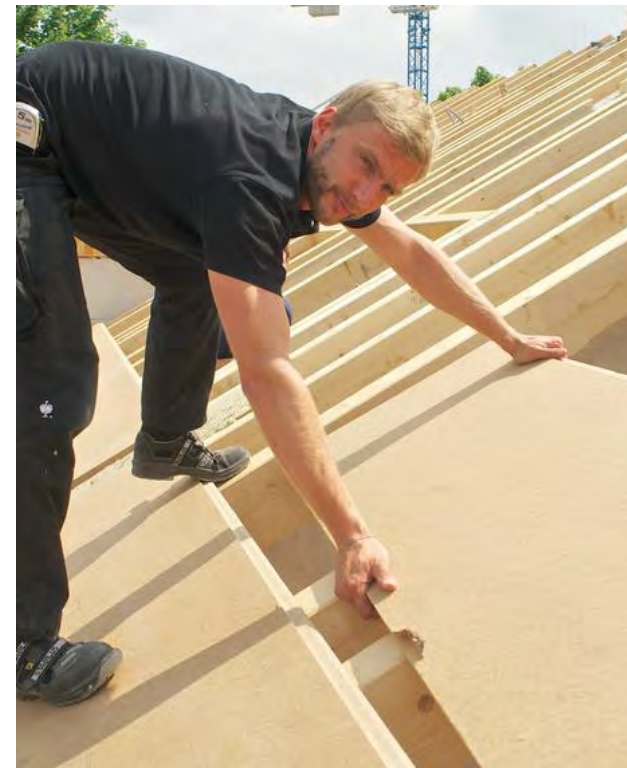
Isolation des toitures
