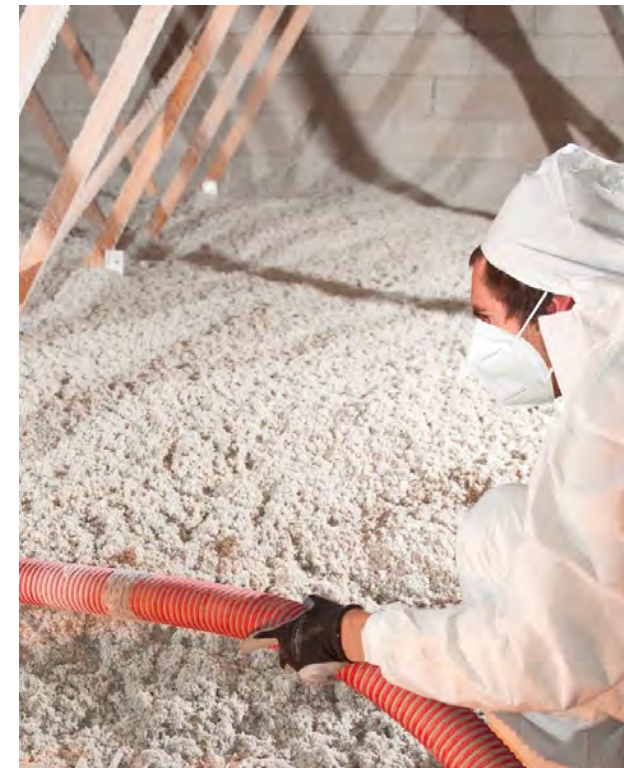
Isolation des combles
